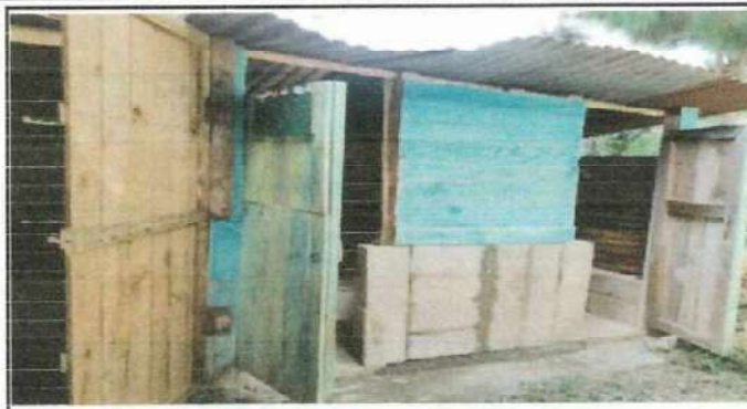
Foto 8: Sustrucción de servicios sanitarios
