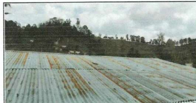
Foto 6: Sustitución de láminas deterioradas.
